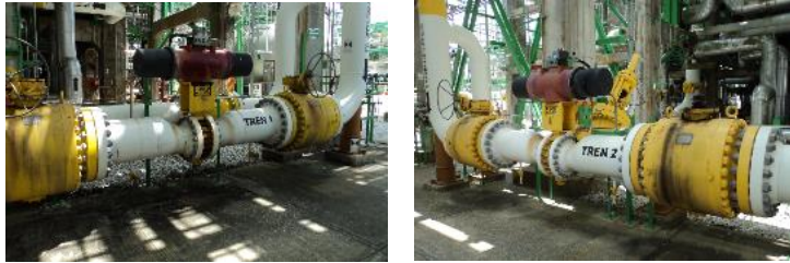
FUENTE: Visita de inspección.
